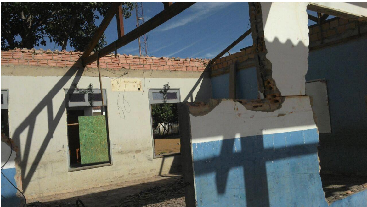
Foto 6: Reforma da escola
