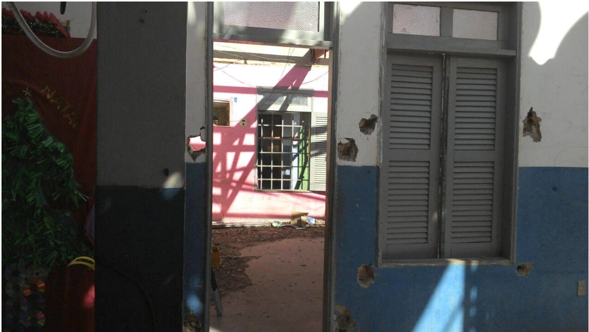
Foto 5: Reforma da escola
