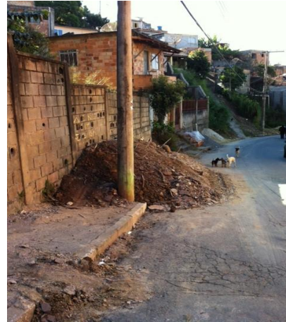
Figura 7: Entulho impedindo acessibilidade de pedestres
