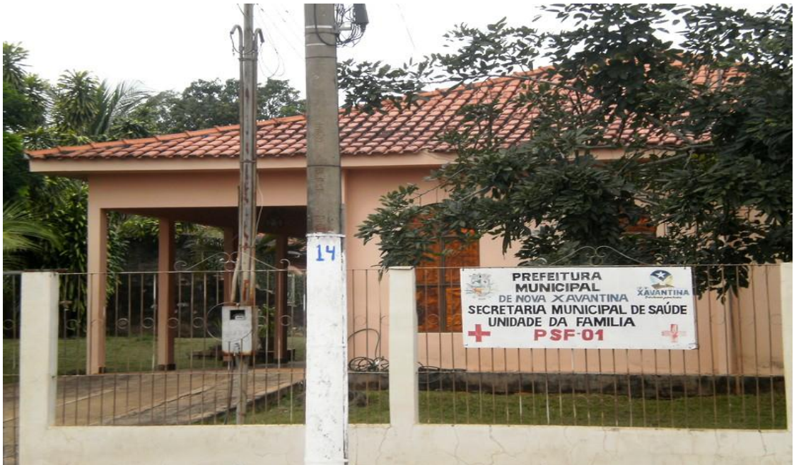
Figura 2- Fachada do prédio provisório da UBS José Fernandes, setor Xavantina, Nova Xavantina-MT, 2013.
