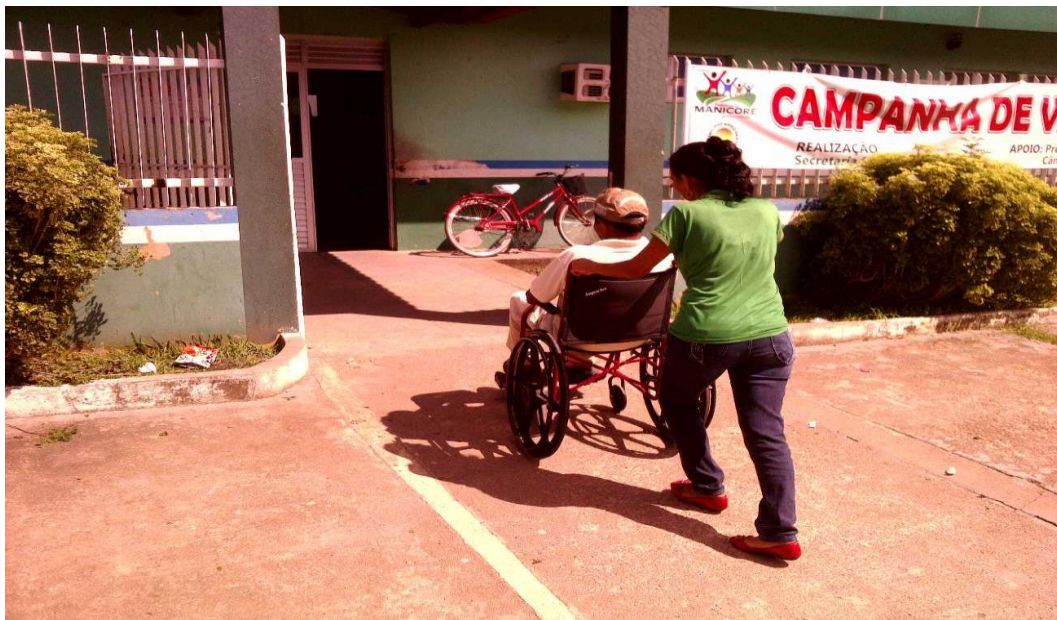
Figura 4 - Rampa de acesso à UBS João Pereira de Oliveira, Manicoré, AM.
