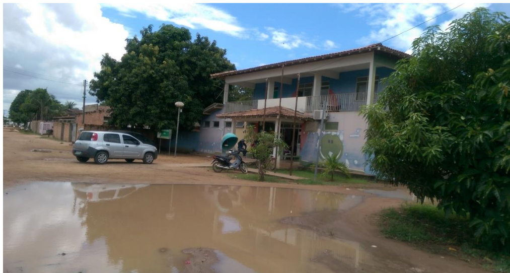
Figura 1- Fotografia da UBS União em situação de chuva.
