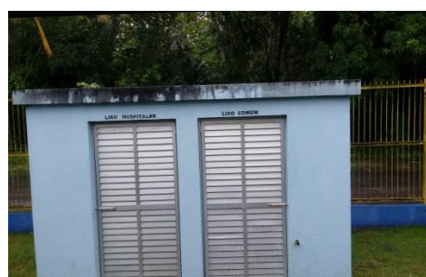
Figura 12: Resíduos sólidos, depósito.
