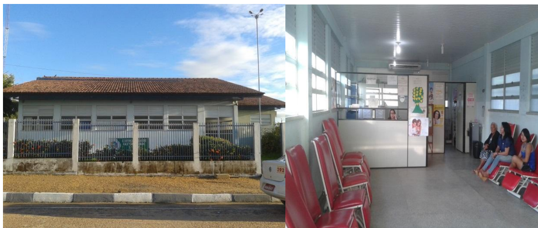
Figura 1- Estrutura externa da UBS e recepção.
