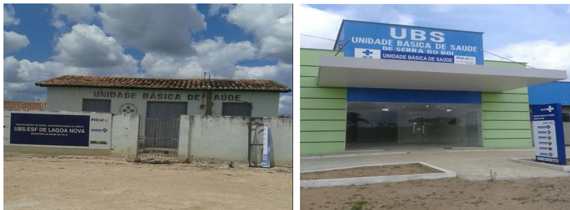
Figura 3: Imagem da UBS onde trabalho e a nova, em construção
