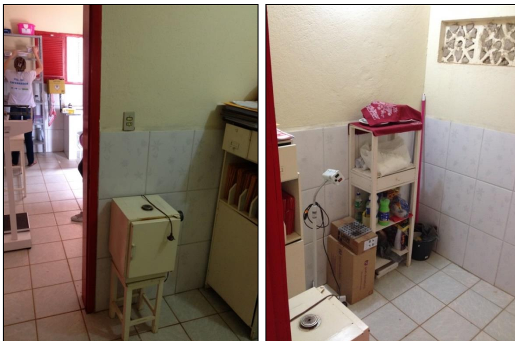
Figura 3: Unidade básica de saúde Isaías Domingos de Queiroz (“Posto de saúde de Tanquinhos”) – Arquivo e local para guardar materias de limpeza.
