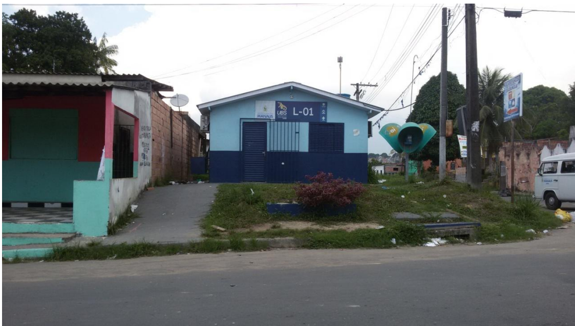
Figura 2 – Vista frontal da UBS. Fonte: Arquivo pessoal.
