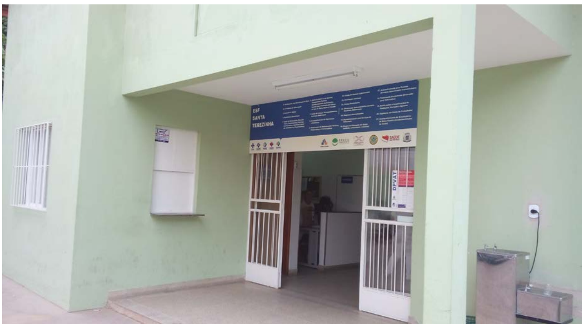
Figura 7: ESF Santa Terezinha após remodelação
