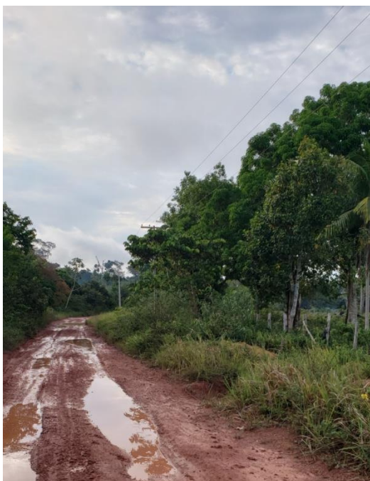
Figura 4- Vista parcial da estrada de barro que dá acesso as comunidades.
