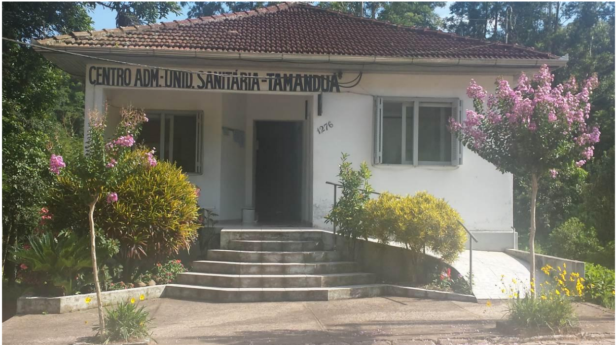
Foto 2. Unidade Sanitária de Tamanduá.
