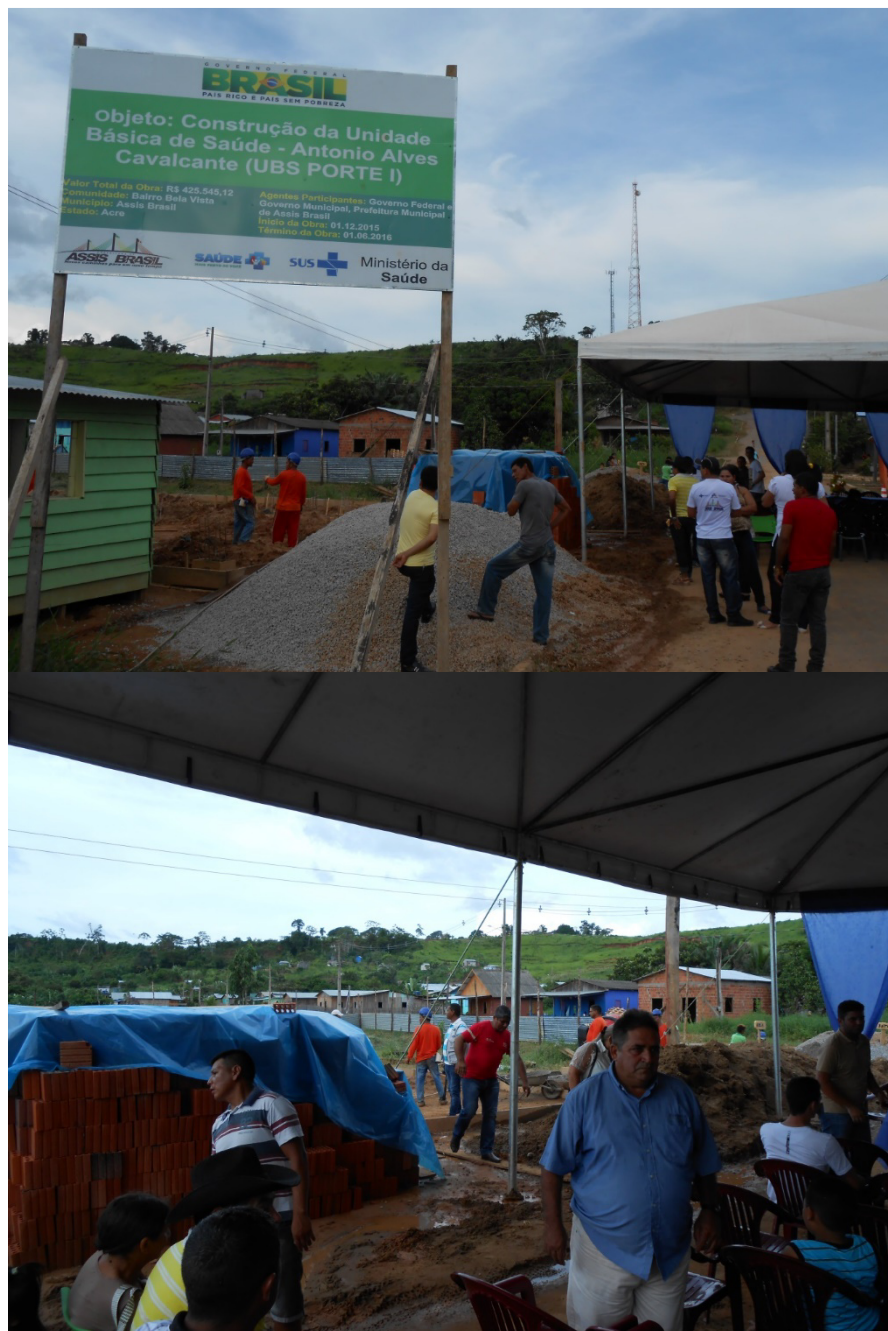
Figura 9. Fotografia de Espaço para construção da nova estrutura da UBS.
