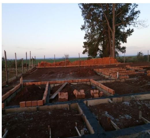
Figura 1 – UBS Capão Bonito em Construção. Fonte arquivo próprio.
