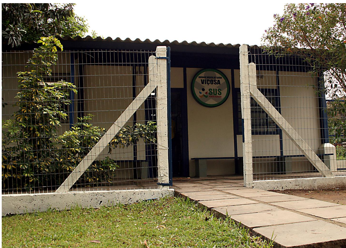
Figura 1: Fachada da ESF - Viçosa (Fonte: portoalegre.rs.gov.br)
